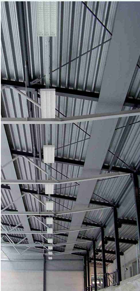
Einsatzbeispiel: Sporthalle Kusel
